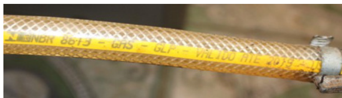
Figura 11 – Mangueira com prazo de validade vencido. A fotografia foi tirada em 20/04/2021.
